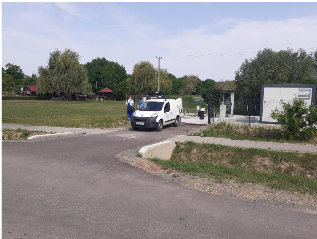
1. kép: Bicsérdi Ady Endre úti átemelő, hrsz 199/2
